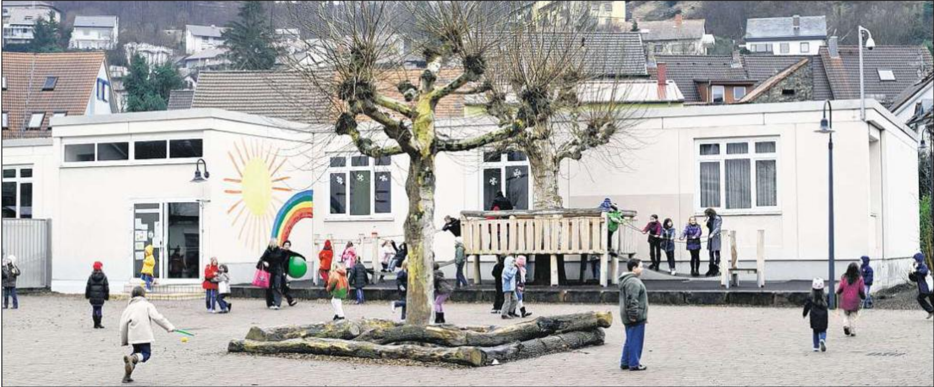
IM E-BAU DER TURMBERGSCHULE in Weingarten soll ab dem kommenden Schuljahr die neue Mensa untergebracht werden. Für das Projekt rechnet die Gemeinde mit staatlichen Fördermitteln in Höhe von knapp 100 000 Euro. Das bestehende Gebäude wird zunächst komplett entkernt, danach werden die Räume neu eingeteilt und mit Küche, Mensa, Spiel- und Ruhezimmer wieder aufgebaut. Foto: Alábisio
