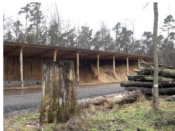
Das Lager für Holzhackschnitzel in der Waldbrücke (mit einem Kuriosum: Die das Dach tragenden Rundhölzer verjüngen sich nach unten.)
